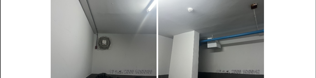
รูปที่ ผ7.39 เครื่องดูดอากาศภายในห้องพักมูลฝอย
