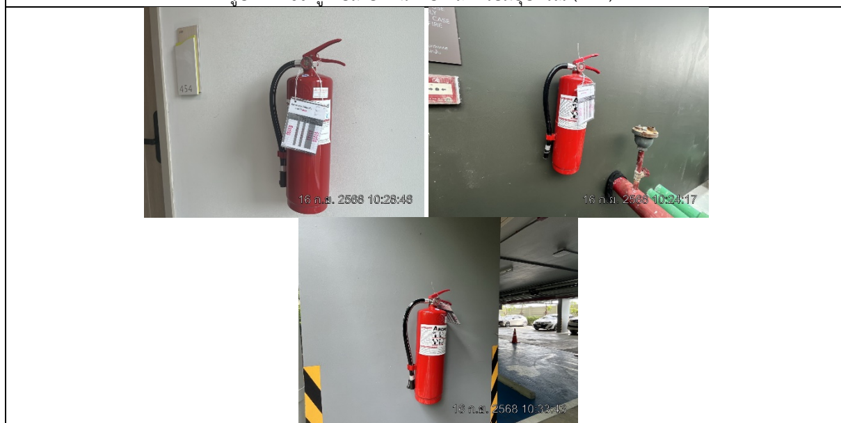
รูปที่ ผ7.61 ถังดับเพลิงมือถือ ชนิดผงเคมีแห้ง (ABC)
