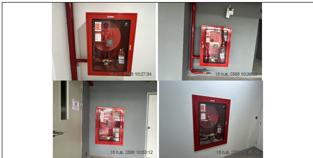
รูปที่ ผ7.60 ตู้เก็บสายฉีดน้ำดับเพลิงพร้อมอุปกรณ์ (FHC)
