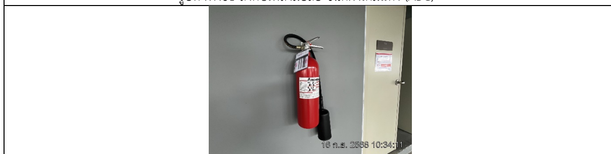
รูปที่ ผ7.62 ถังดับเพลิงมือถือ ชนิดก๊าซคาร์บอนไดออกไซด์ (CO 2 )
